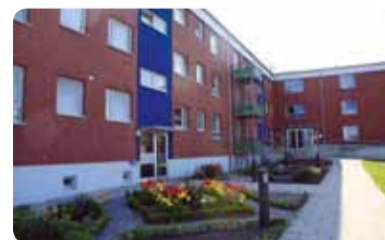
Die Seniorenwohnanlage mit angrenzendem Bistro.
