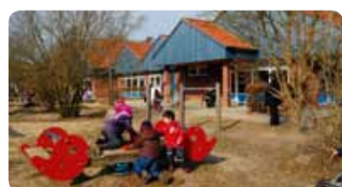
Umfangreicher Umbau in der städtischen Kita
