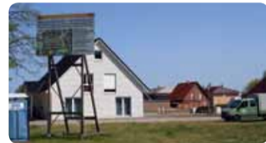
Das Neubaugebiet „Stockfeld“.
